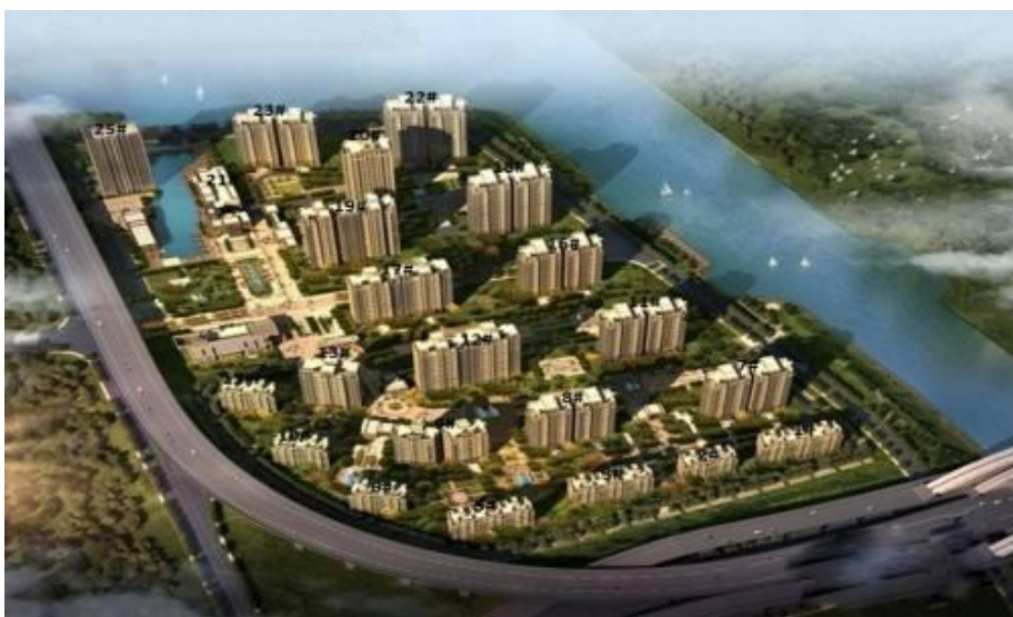
二手住宅：江苏天之运花园项目，共计29.8万方
